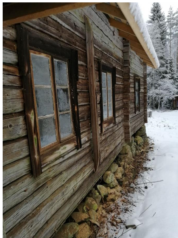
Rakennukseen tehtiin uudet kattotuolit ja uusi katto.
