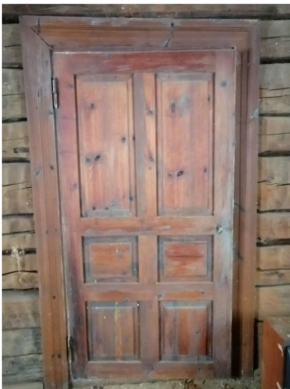
Kaunis ovi johtaa peräkammareihin, joiden väliseinä on jossain vaiheessa purettu pois.
